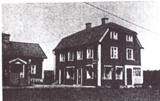
Bild 6. Ulvebo Lilla 1 r , Minnet, Söderköping: Vid busshpl. 720 kvm. Tax. 16.400 (400, 16.000). Förvärvad 1949. Trä, omkr. 1860, 1 affärslokal, 1 kontor, 1 lagerrum samt 1 bost.läg. om 5 rum, 1 kök, 1 hall. Omb. 1927, mod. 1942. El, v, avl, cv. Firma: Bottna Specerier. — Köpman Erland Johansson samt köpman Gunnar Andersson.
