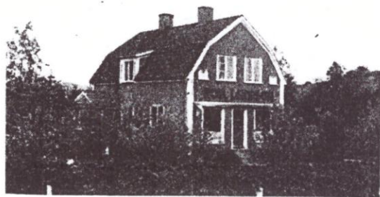
Bild 5. Bråta 3 2 , Bergdala, Söderköping: Vid busshpl. 1.423 kvm. Taxeringsvärde 10.000 kronor, därav mark 600, byggnad 9.400. Förvärvad 1932. Fastigheten av trä, uppförd 1933, innehållande 3 rum, 1 kök, 1 hall, 1 affärslokal, 1 kontor, 1 lagerrum. Bekvämligheter: El, v, avl, cv. Firma: Robert Larssons Specerier och diversehandel. — Köpman Robert och Thyra Larsson.
